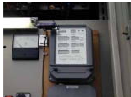
光電センサによる電力パルス読出装置
