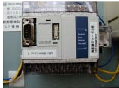
電力利用合理化に取り組まれているお客様に取り付けたシーケンサ電力データ収集装置
